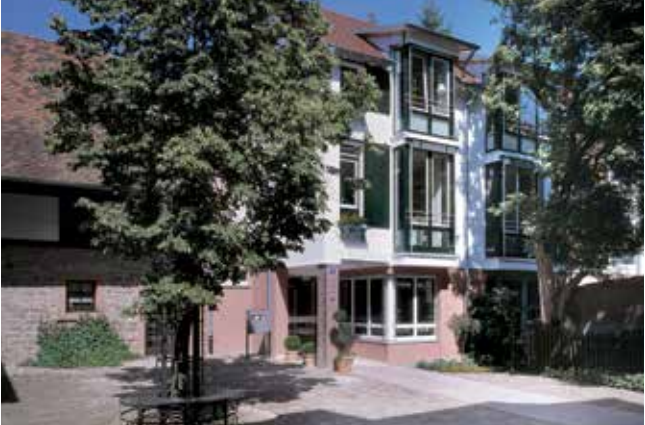
Blick auf den Eingang
